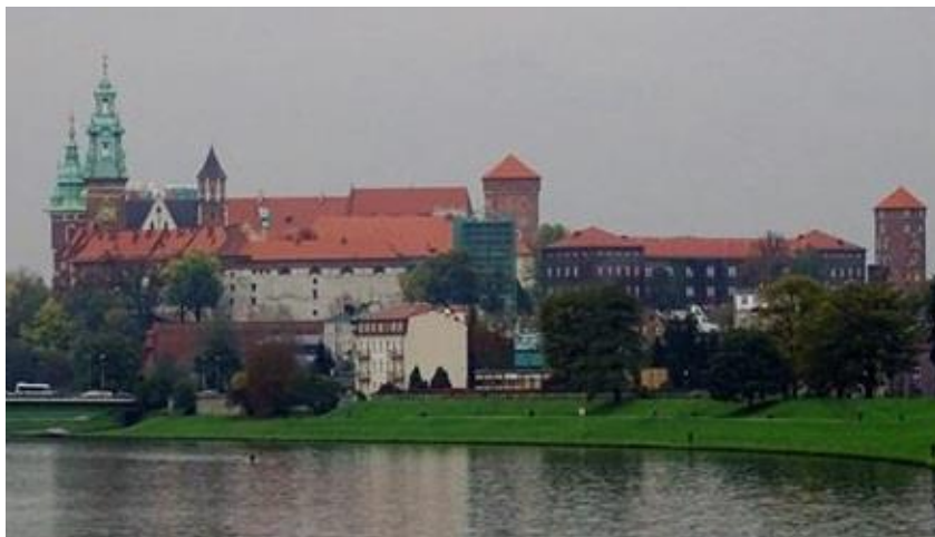
Widok z okna domu, w którym się urodziłem (ul. Dojazdowa 5)
